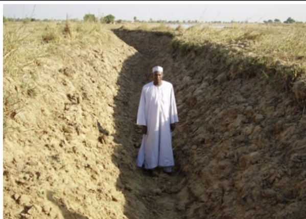
Photo 2 : Mare naturelle reliée à un cours d'eau par un canal pêche : 4 m de large et 2, 5 m de profondeur Cliché : ACEEN, 2006
